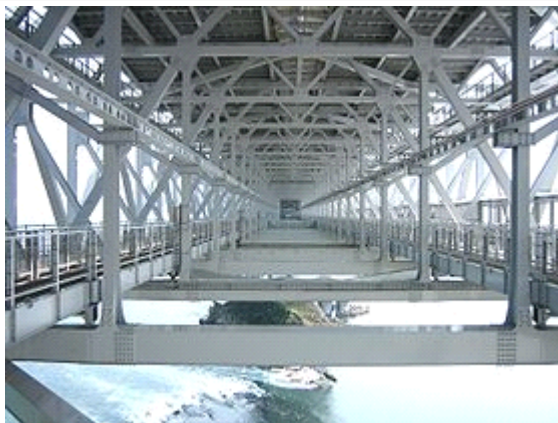
橋の下層。将来的に新幹線が通せる構造になっている。
