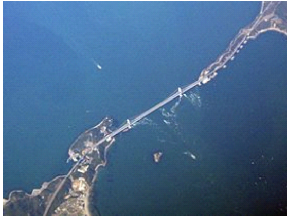
上空から見た橋。(2007年3月)
