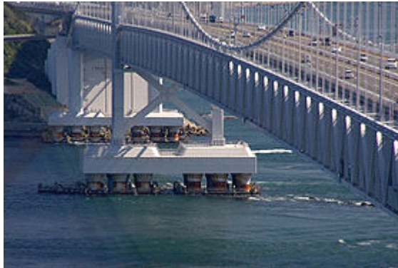
橋脚。渦潮への影響を最小限に抑えるためにユニークな多柱基礎構造を採用した。
